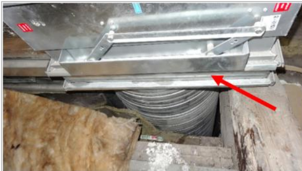
Att. V3. Ugunsdrošības vārstu uzstādīšana neatbilst ugunsdrošības noteikumiem un ražotāja tehnoloģiskajiem risinājumiem.
