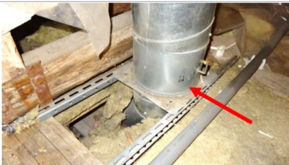
Att. V3. Ugunsdrošības vārstu uzstādīšana neatbilst ugunsdrošības noteikumiem un ražotāja tehnoloģiskajiem risinājumiem.
