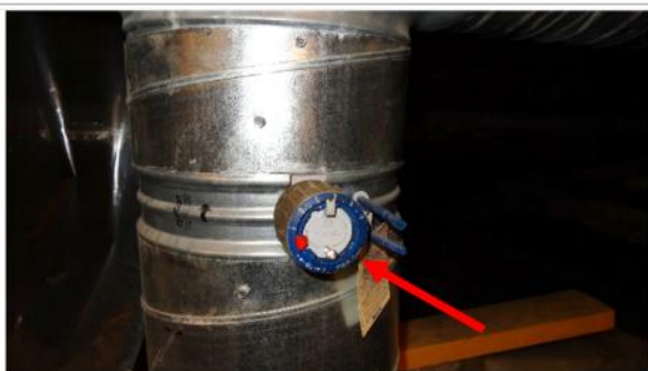
Att. V3. Ugunsdrošības vārstu uzstādīšana neatbilst ugunsdrošības noteikumiem un ražotāja tehnoloģiskajiem risinājumiem.
