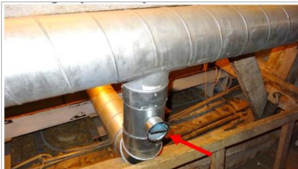
Att. V4. Daļa no regulēšanas vārstiem atrodas aizvērtā stāvoklī.
