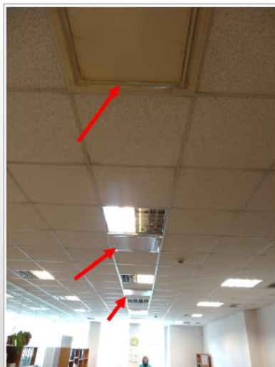
Att.1. Pieplūdes difuzors aizlīmēts ar līmlenti.
