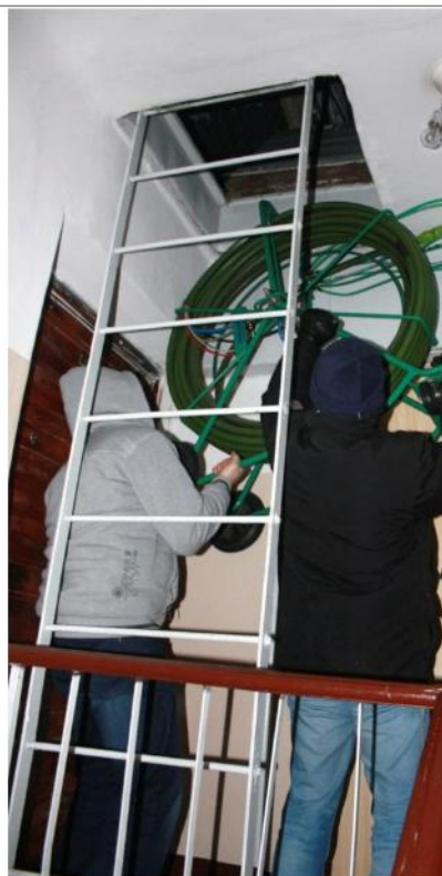
Foto 1. Tīrīšanas iekārtu (atbilst tehniskas specifikācijas prasībām) gabarītmēri pārsniedz jumta lūkas izmērus.
