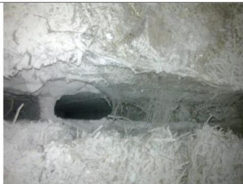
Foto 3. Dabīgas nosūces kanāli ar izmēriem 70x150 mm.
