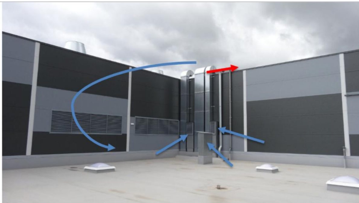
Att. V15. PN1 gaisa izmešana un PN1, PN2, PN3 gaisa ieņemšanas.
