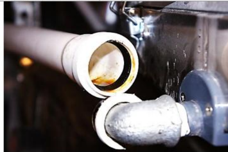
Foto 5. Tvaiku kondensāts siltuma atgūšanas sekcija
